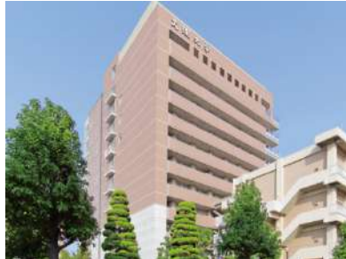
A：薬学部（24号館）
